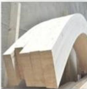
пород. Порода древесины определяют по назначению и условиям эксплуатации конструкций. Для изготовления несущих конструкций используются в основном пиломатериалы хвойных пород (сосна, ель, лиственница).
