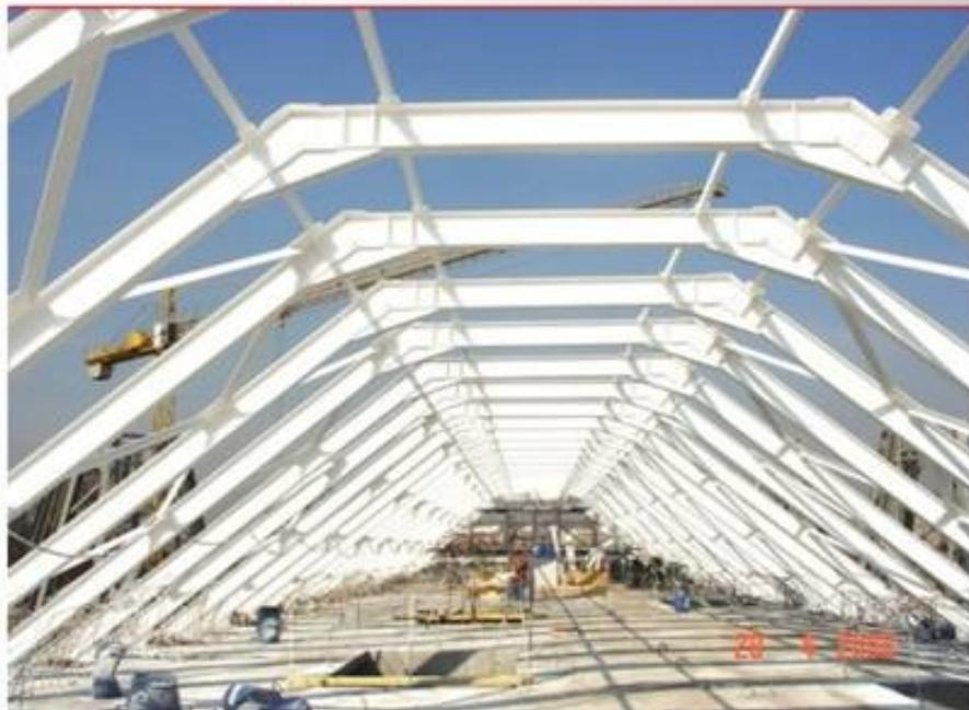
фоне иных огнезащитных средств. Во-первых, краски образуют покрытие с малой толщиной и весом. Они не утяжеляют конструкции в отличие от облицовочных материалов и теплоотражающих экранов. Во-вторых, данное покрытие легко восстанавливается после повреждения или по истечении срока эксплуатации. В-третьих, **огнезащитное покрытие** выполняет двойную функцию: непосредственно защищает поверхность от огня и придает ей декоративный внешний вид.
