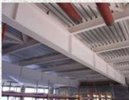
Огнезащитная эффективность средств огнезащиты в зависимости от наступления предельного состояния (достижение образцом критической температуры 500 С<sup>0</sup>) подразделяется на 7 групп согласно ГОСТ Р 53295—2009.
